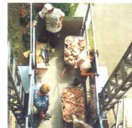
Грузовая платформа предназначена для транспортировки крупногабаритных и тяжелых грузов. Грузовая платформа типа „В“ размером 1,45 x 3,3 м.
