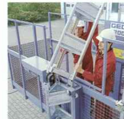
Удобная сборка стальных оцинкованных мачтовых секций высотой 1,5 м с использованием невыпадающих болтов (M16) и гаек
