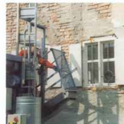
Для крепления мачты к стене без применения строительных лесов используется модифицируемый монтажный щит
