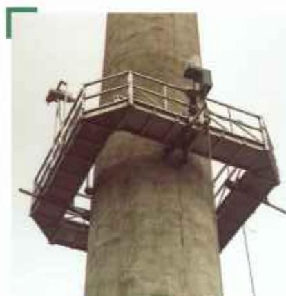
Durch Eckstücke kann die Plattform den Gebäudegegebenheiten angepaßt werden.
