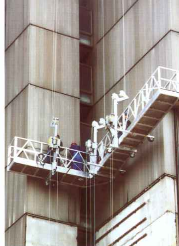
Mittels spezieller Steuerungen lassen sich bis zu 4 Antriebe gleichzeitig betreiben. Damit sind auch größere Bühnenverbände möglich.
