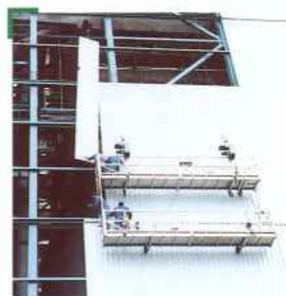
Bei der Montage von Fassadenplatten wird oft die Doppelstockvariante eingesetzt, um die Elemente an mehreren Stellen gleichzeitig fixieren zu können.
