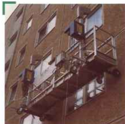
Bei der Sanierung von Betonfassaden, speziell von sogenannten Plattenbauten, zeigt sich die Arbeitsbühne anderen Lösungen durch wesentlich verringerte Rüstzeiten und geringe Betriebskosten überlegen.
