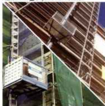
Зубчато-реечные подъемники с алюминиевой мантой или стальной мантой
