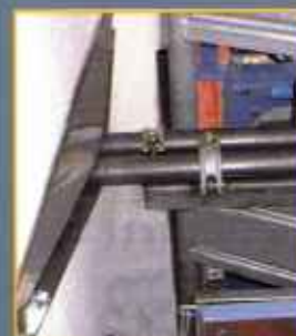
Крепление мачты к стене
