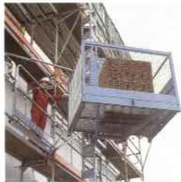
Zahnstangenauflüge mit Stahlmast
