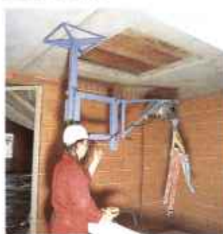
Mit der Geschoßstütze ist ein Einsatz auch unter schwierigen Bedingungen (z. B. im Treppenhause) möglich.
