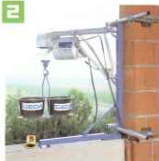
Der Fensterklemmarm – einstellbar für Mauerstärken von 16 - 50 cm – ist eine praktische Befestigung für jeden Rohbau. Bei vorhandenem Fensterstock können die Auflagepunkte verschoben werden.
