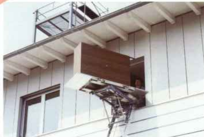
Die verfahrbare Drehbühne bleibt – durch Endschalter gesteuert – direkt vor dem Fenster stehen
